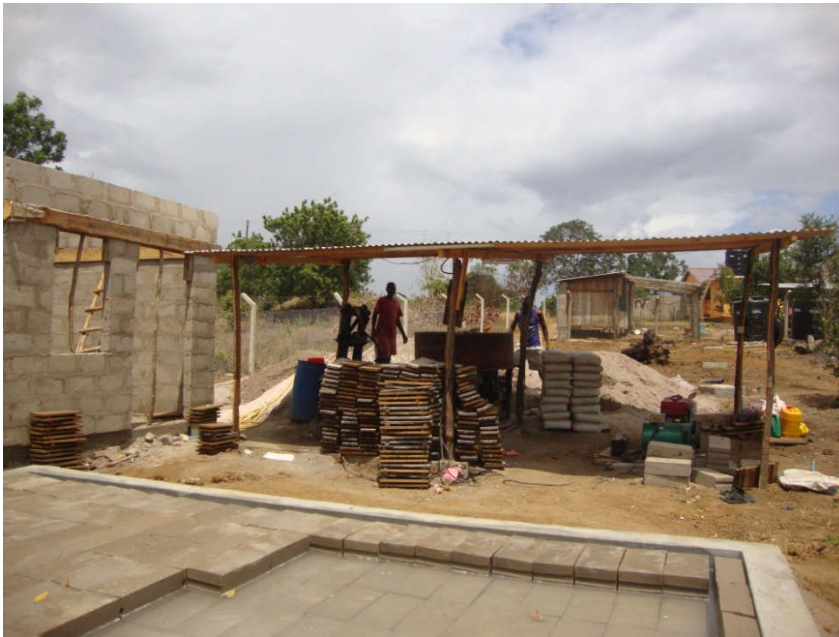
Das Fundament für das entstehende Haupthaus der Kinder wird errichtet.
